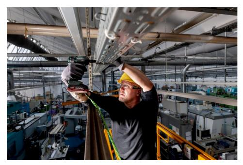
Ils protègent sans gêner : les mousquetons des nouvelles sangles de protection pour outils Metabo tournent à 360°. La sangle peut ainsi être utilisée dans toutes les positions de travail et permet une grande liberté de mouvement, car le mousqueton tourne et accompagne le mouvement. **Photo : Metabo**
